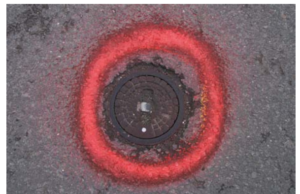
Bild 6: Kennzeichnung an Straßenkappe nach Ertüchtigung: grün (ertüchtigt), rot (defekt)
