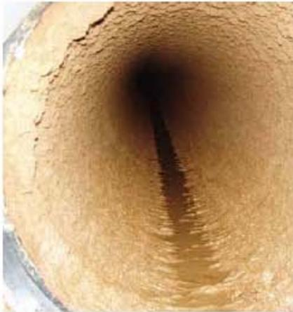
*Vor der Reinigung: Die zentimeterdicke Schlammablagerung ist im Rohr deutlich zu erkennen. Sie verringert zunehmend den Durchfluss.*
