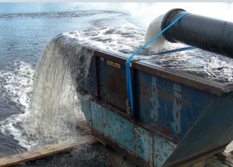
Bild 5: Ausspeisung beim Reinigen mit dem Impulsspülverfahren
