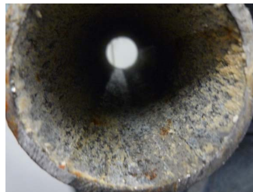
Abbildung 3: Zustand der KSS-Leitung nach der Comprex®-Reinigung
