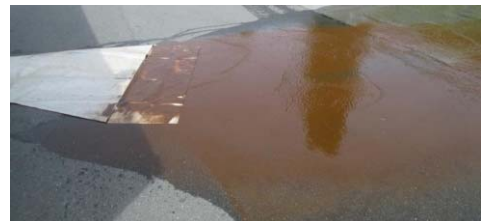
Abbildung 3: Trübung an der Ausspeisestelle während der Reinigung
