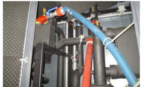
Abbildung 2: Zugang zum System über einfache Adapteranschlüsse
