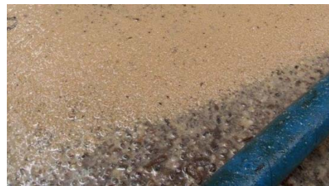
Abbildung 5: ausgetragene wachsartige Ablagerungen
