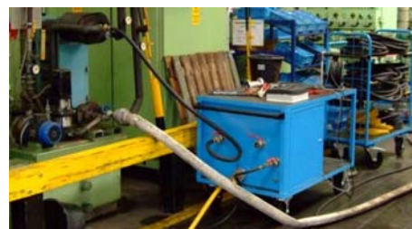
Abbildung 3: Reinigen eines Plattenwärmeübertragers mit mobiler Comprex®-Einheit
