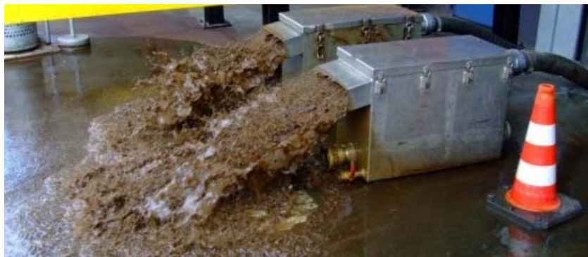
Abbildung 1: Ausspeisestelle mit Spülboxen
