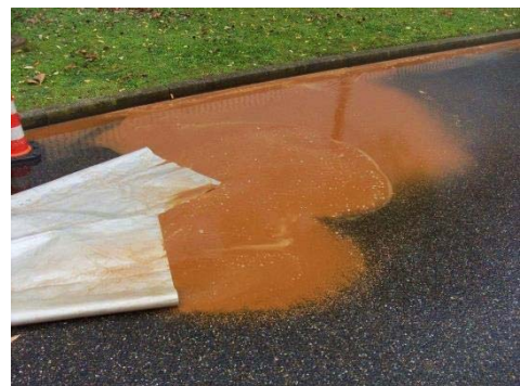
Abbildung 3: durch ausgetragene Ablagerungen verfärbtes Spülwasser am Auslauf
