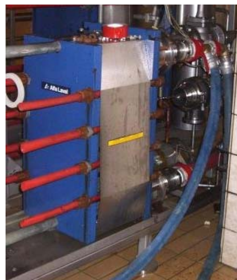
Abbildung 2: gedichteter / geschraubter Plattenwärmeübertrager (Symbolbild)
