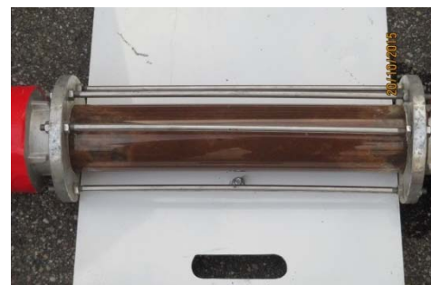
Abbildung 4: Trübung im Schauglas während der Comprex®-Reinigung
