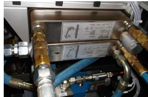
Abbildung 2: gelöteter Plattenwärmeübertrager während der Reinigung
