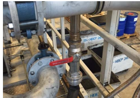
Abbildung 2: Einspeisung von Luft und Wasser in das System über Adapter
