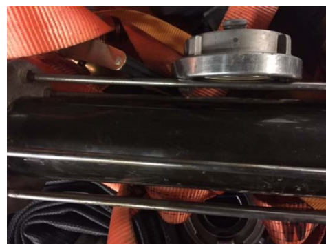
Abbildung 4: Trübung im Schauglas während der Comprex®-Reinigung
