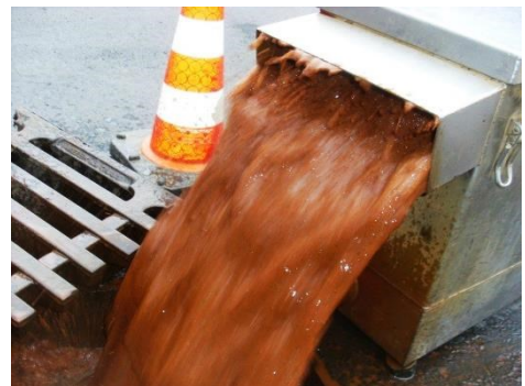
Abbildung 4: Trübung des Spülwassers an der Ausspeisestelle (Auslaufbox)
