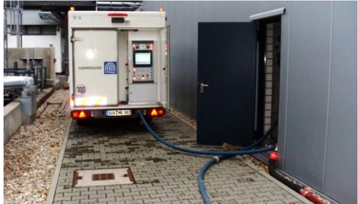
Abbildung 1: Comprex®-Einheit im Einsatz
