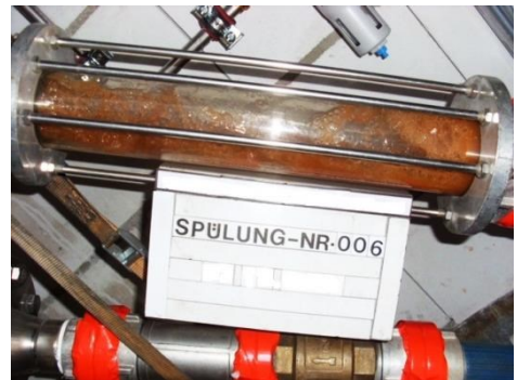
Abbildung 3: Trübung in Schauglas als Anzeige für den Reinigungsfortschritt
