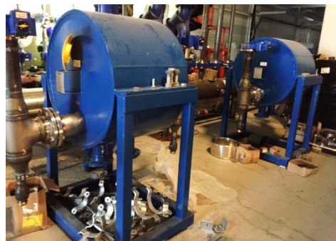
Abbildung 2: Im System enthaltene Wärmeübertrager
