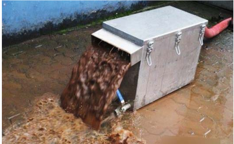
Abbildung 1: Trübung durch gelöste Ablagerungen an Auslaufbox
