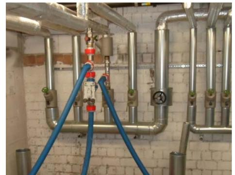
Abbildung 1: Einspeisung über Adapteranschlüsse
