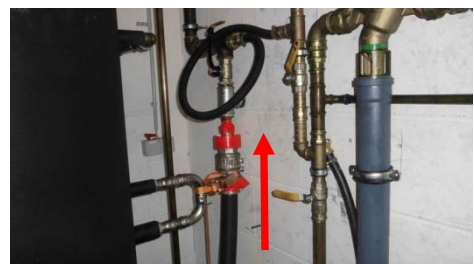
Abbildung 3: Druckluftspeisung über Adapteranschlüsse
