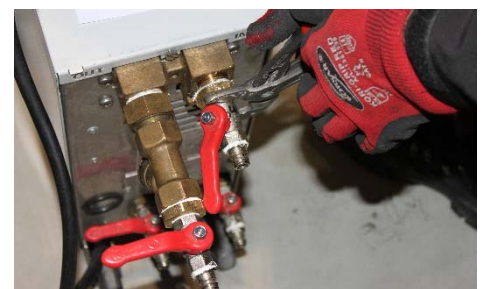
Abbildung 4: Vorbereiten der Anschlüsse
