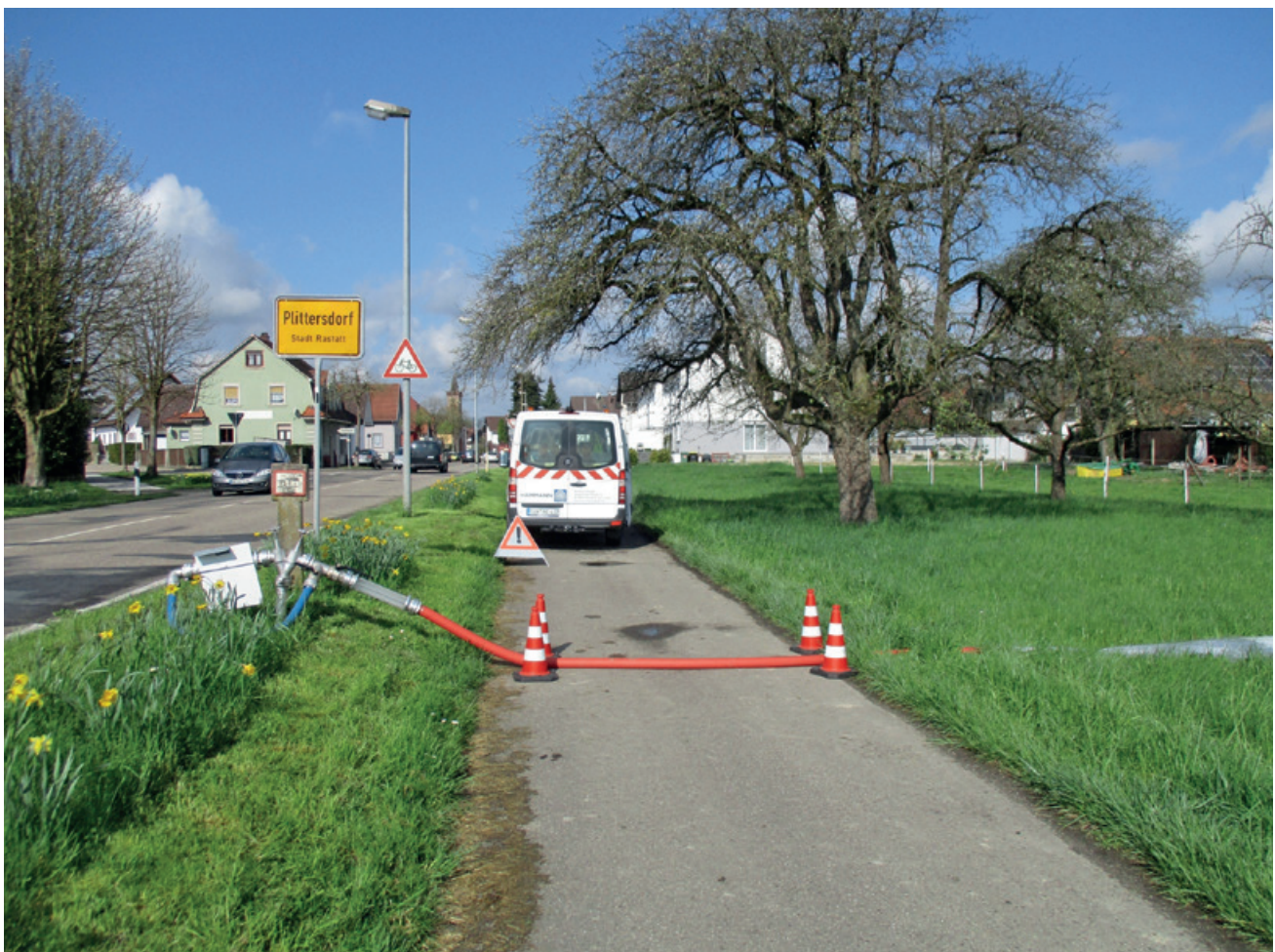
Abb. 1: Comprex-Reinigung im Rastatter Ortsteil Plittersdorf
