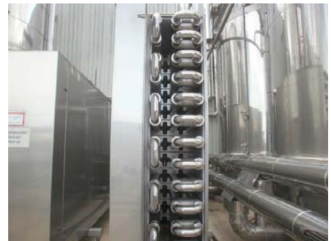
Abbildung 2: Doppelrohrwärmetauscher
