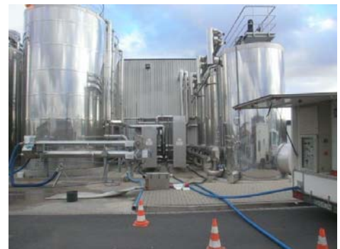
Abbildung 3: Comprex®-Technik vor Ort
