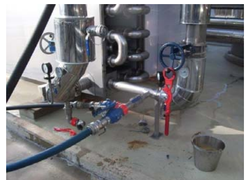
Abbildung 4: Einspeisung von Luft und Wasser über Adapteranschlüsse
