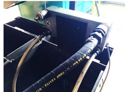
Abbildung 2: Plattenwärmetauscher während der Reinigung
