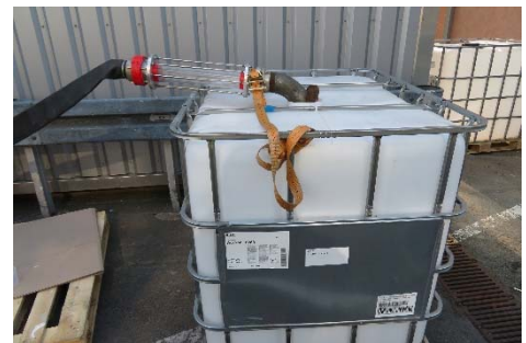
Abbildung 2: Ausspeisung von Spülwasser mit Ablagerungen in IBC
