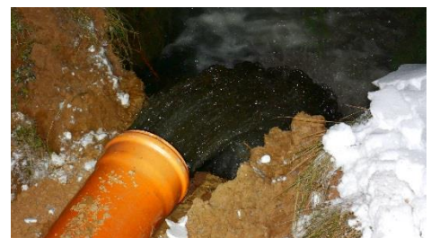
Abbildung 5: Spülwasser mit mobilisierten Ablagerungen an Ausspeisestelle
