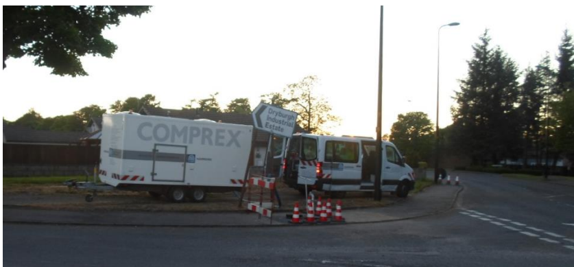
Abbildung 1: Comprex®-Technik im Einsatz
