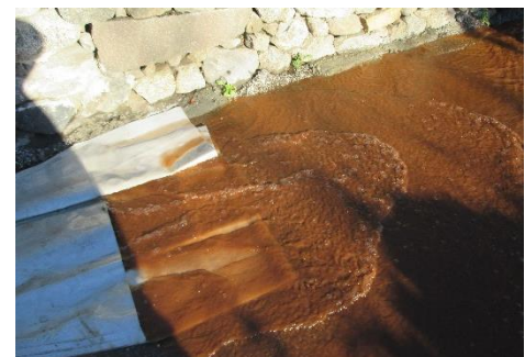
Abbildung 5: Spülwasser mit Trübung an der Ausspeisestelle
