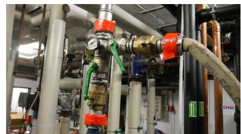
Abbildung 4: Luft- und Wassereinspeisung
