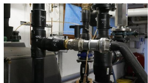
Abbildung 5: Ausspeisung für Luft und Spülwasser mit Adapteranschlüssen
