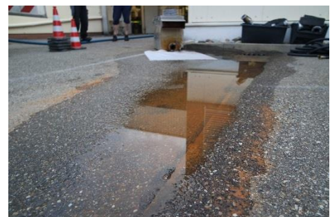
Abbildung 5: Ausgetragene Ablagerungen an der Ausspeisestelle
