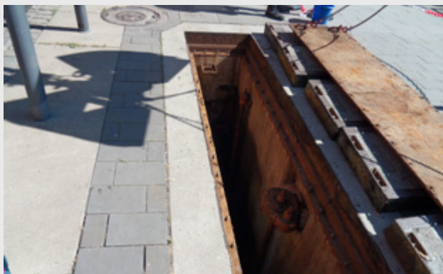
Bild 5: Geöffneter Hauptschacht des Auslaufbauwerks mit Einstieg und zusätzliche runde geschlossene Schachtabdeckung
