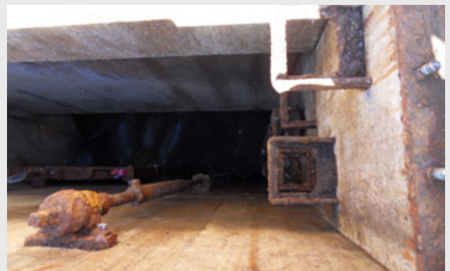
Bild 5: Geöffneter Hauptschacht des Auslaufbauwerks mit Einstieg und zusätzliche runde geschlossene Schachtabdeckung
