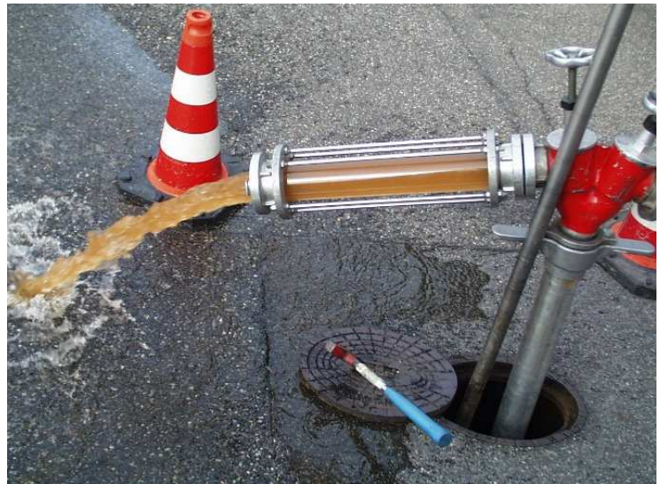
Abbildung 1: Funktionsprüfung an Hydrant
