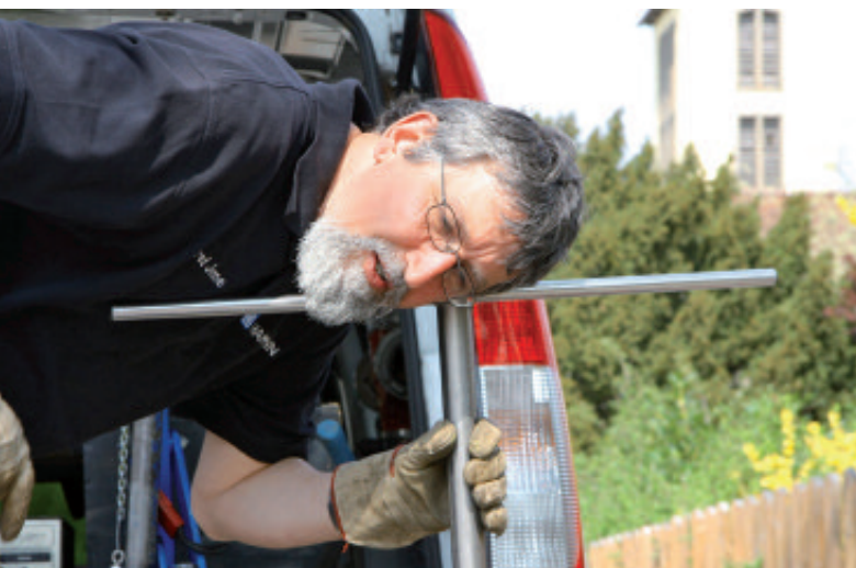
Abb. 1: Abhören eines Schiebers
