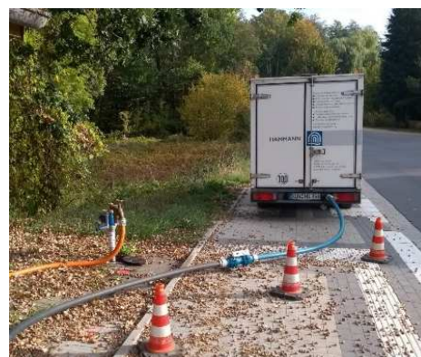
Abbildung 2: Comprex®-Einheit im Einsatz
