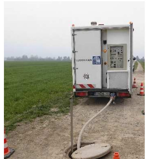
Abbildung 2: Einspeisung am Schacht
