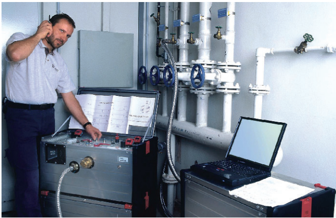
Bild 2 Anschluss der Impuls-Spülbox an eine Steigleitung
