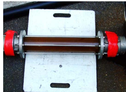
Abbildung 3: Trübung in Schauglas während der Comprex®-Reinigung
