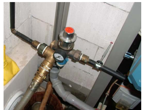
Abbildung 2: Einspeisung über Adapteranschlüsse
