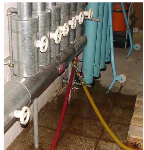
Abbildung 1: Einspeisung von Luft über Adapteranschlüsse
