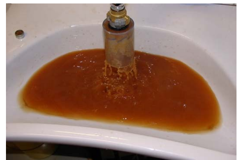
Abbildung 2: Trübung bei Ausspeisung über Waschbecken mit Zyklonabscheider
