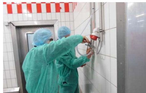
Abbildung 2: Herstellen der Schlauchverbindungen
