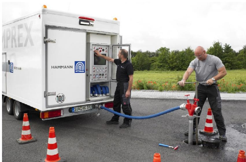
**Bild 1:** Konventionelle Comprex-Einheit bei der Rohrnetzspülung
