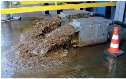
Abb. 4: Austrag von Verunreinigungen aus einem industriellen Kühlsystem.
