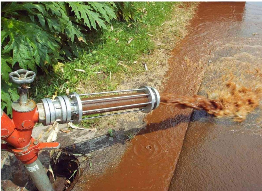
Bild 2: Austrag von Ablagerungen beim Impulsspülverfahren
