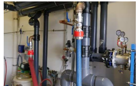
Abbildung 3: Anschluss an Vor- und Rücklauf mit Adapteranschlüssen
