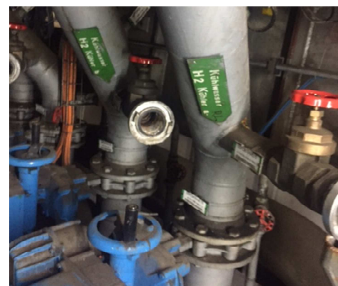
Abbildung 4: Adapteranschluss des Kühlwasservorlaufes
