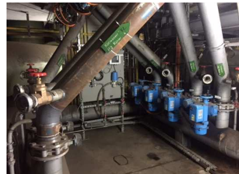
Abbildung 3: Vor- und Rückläufe des Kühlkreislaufes
