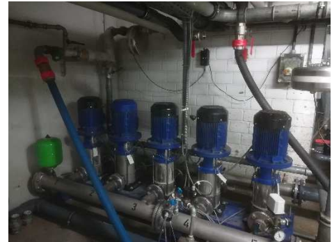
Abbildung 2: Vor- und Rücklauf des Kühlkreislaufes
