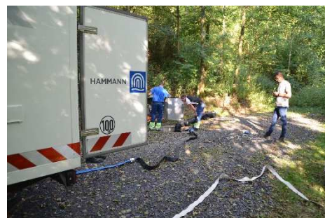
Abbildung 3: Einspeisung in Schacht
