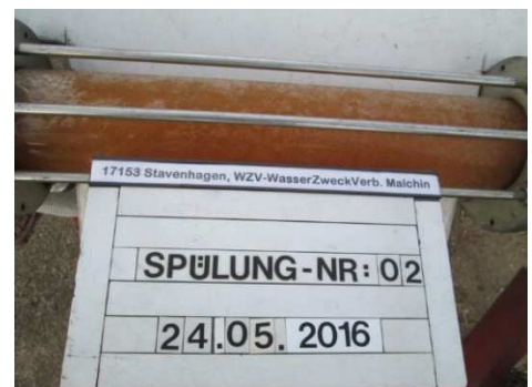
Abbildung 4: Schauglas an Ausspeisestelle
