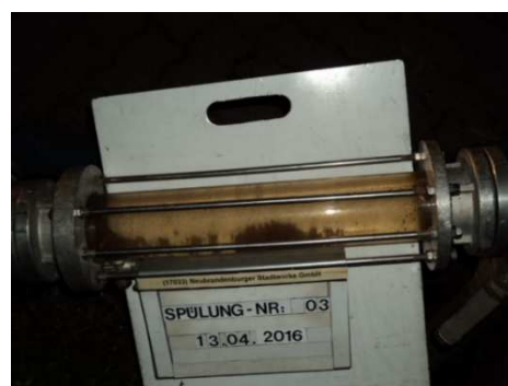
Abbildung 4: Schauglas an Ausspeisestelle
