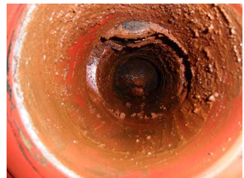
Abbildung 3: Zustand nach der Reinigung
