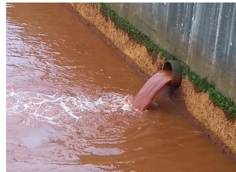
Abbildung 3: Freier Auslauf am Wasserwerk
