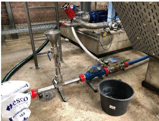
Abbildung 7: Aufbau zur Steinsalzzugabe
