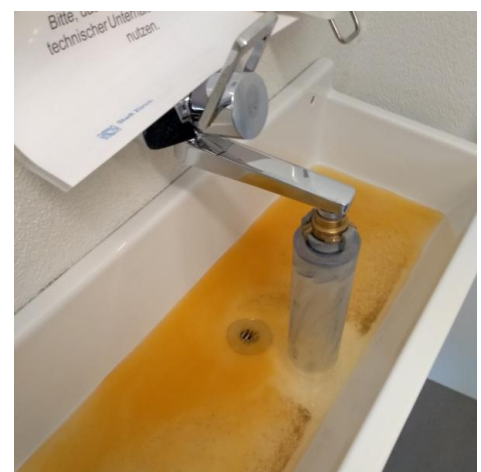
Abbildung 3: Austrag von Ablagerungen während der Complex®-Reinigung
