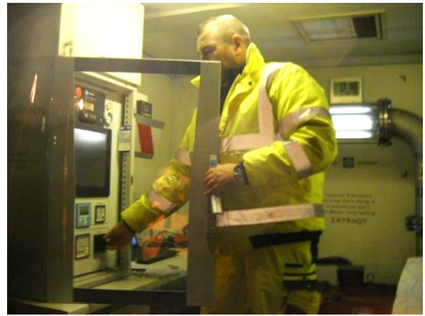
Abbildung 1: Techniker im Einsatz
